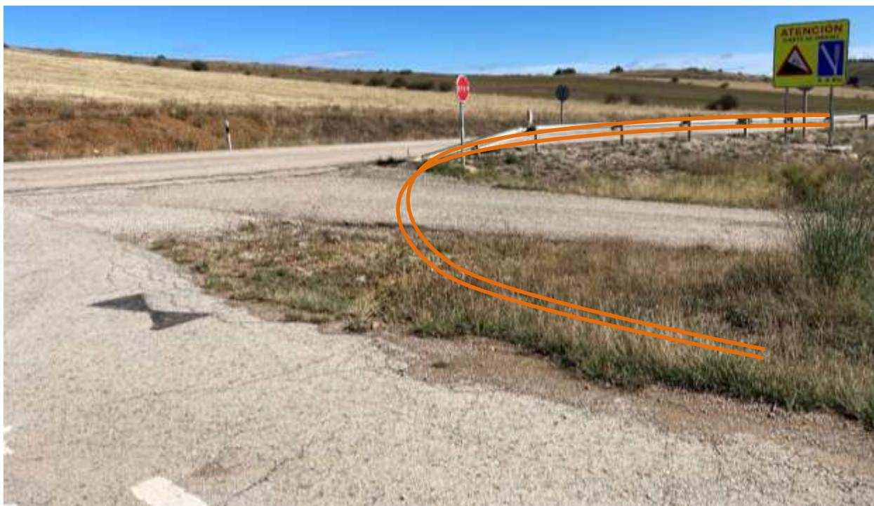
Disposición esquemática de la barrera de seguridad metálica clausurando el acceso existente.
